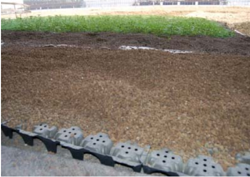
Şek.3 Yeşil teras zemininin tabakalar halinde görünümü
